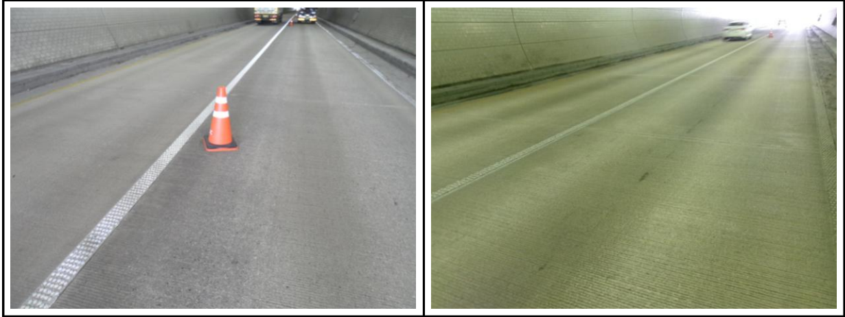
【사진 1.3.11】 포장부 전경
