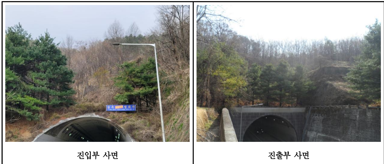
【사진 1.3.13】 사면 전경
