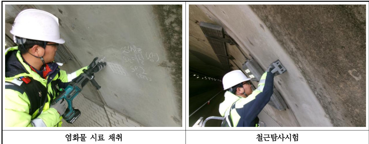
【사진 1.4.3】 염화물 침투량 시험 현장사진
