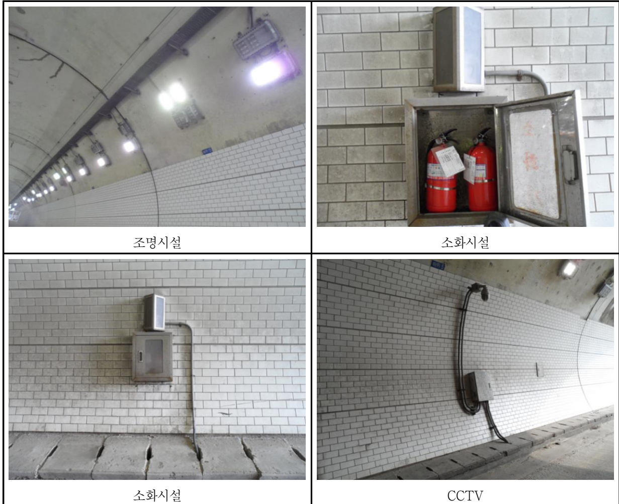
【사진 1.3.17】 부속시설 전경
