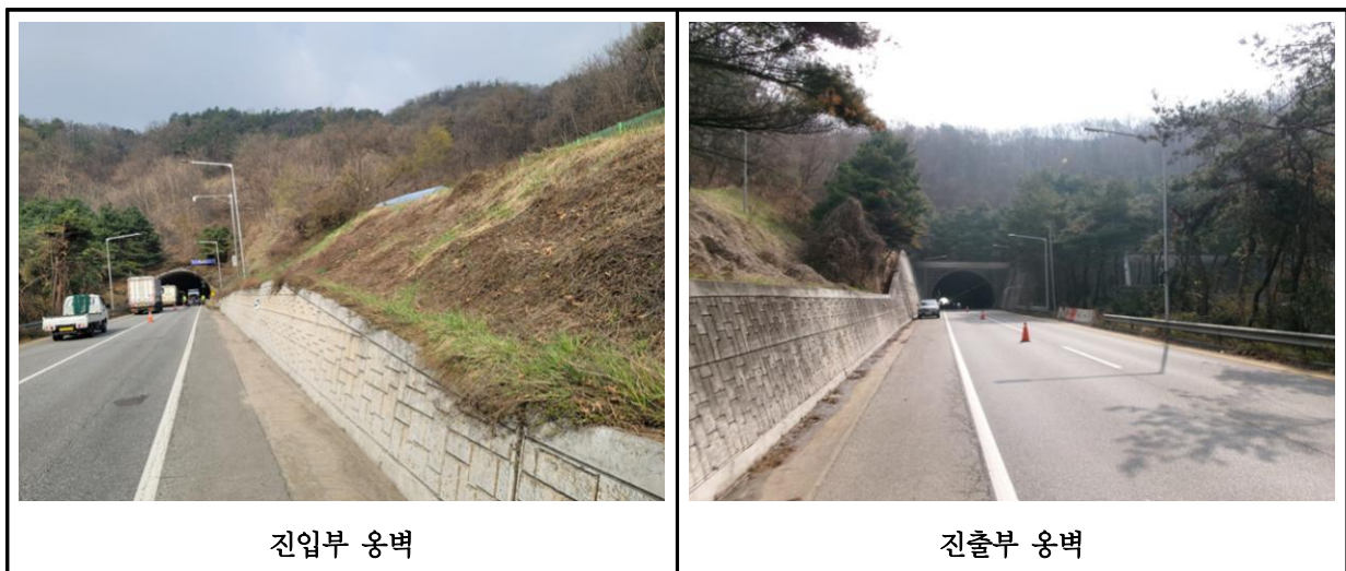
【사진 1.3.15】 옹벽 전경
