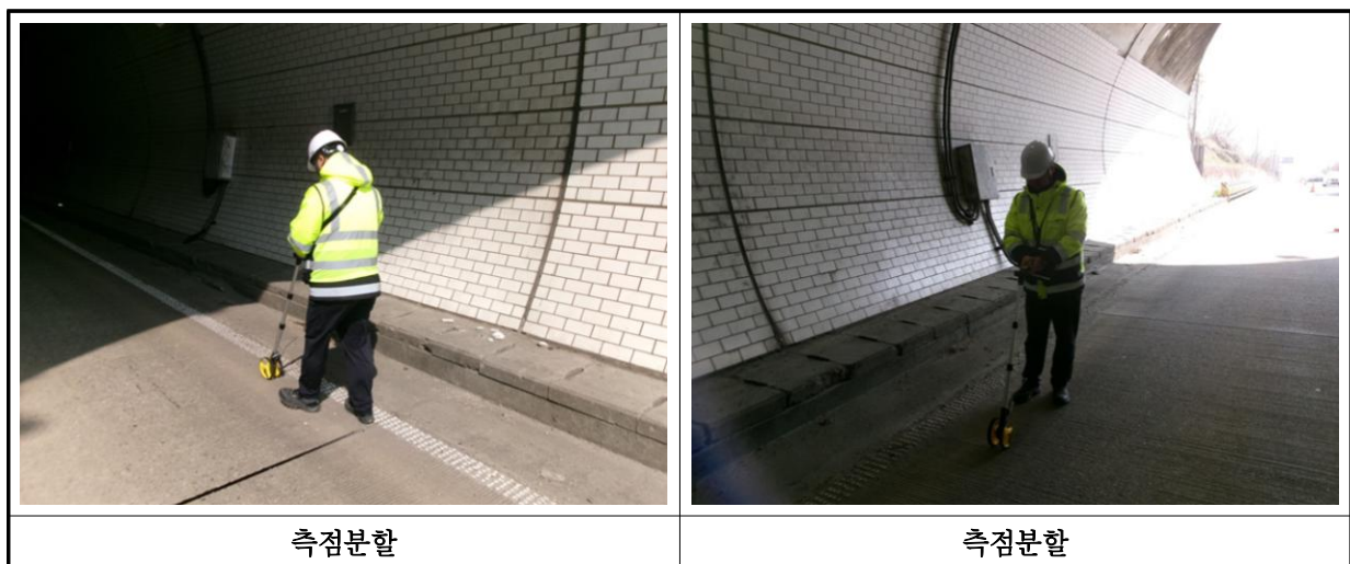
【사진 1.5.1】 측점분할 현장사진
