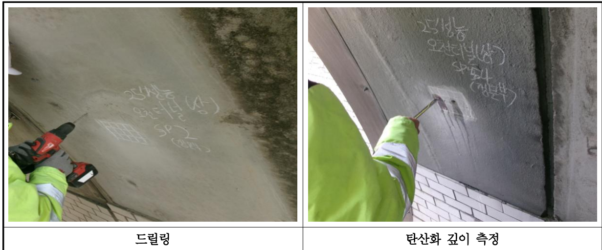
【사진 1.4.2】 탄산화 깊이 시험 현장사진
