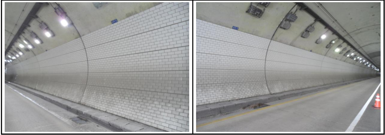
【사진 1.3.3】 측벽부 전경
