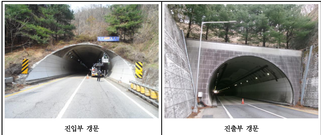
【사진 1.3.5】 갯문 전경
